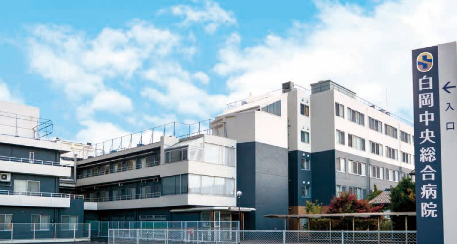
●白岡中央総合病院外観
